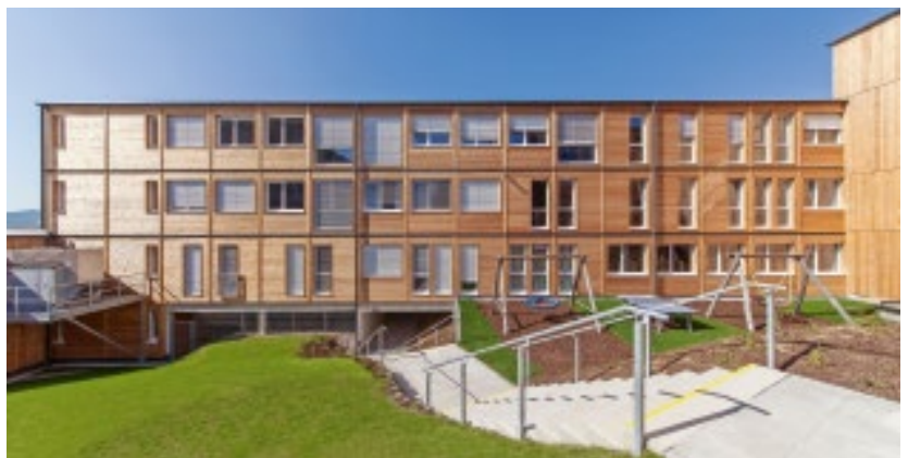
Das Ersatzquartier für die Ganztageschule und neue Mittelschule Kinkplatz in Wien, das in modularer und wiederverwendbarer Holz-Stahl-Fertigbauweise errichtet wurde, erfüllt alle Anforderungen an einen modernen Schulbetrieb.
