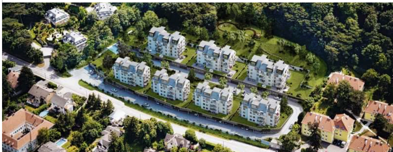
GARTENPARK am kleinen Anninger: Der Wohnpark der IG-Immobilien ist ein zertifiziertes Projekt mit energieeffizienten Wohneinheiten
