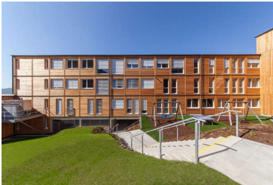
Die modulare Holz-Stahl-Konstruktion kann bis zu fünf Mal ab- und wieder aufgebaut werden. Foto: © Romana Fürnkranz
